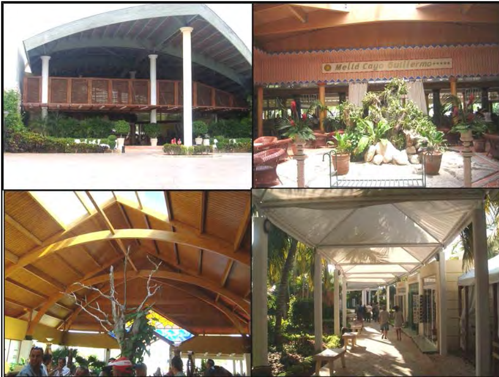
FIGURA 4.3. Característica arquitectura del lobby de los hoteles de playa de la cayería; se observan los altos puntales que dejan libre la mayoría de las paredes laterales y permiten una amplia conexión visual entre los corredores, las áreas exteriores y los jardines. (Fotos: Sergio Ferro y Oliesky Fabre)
