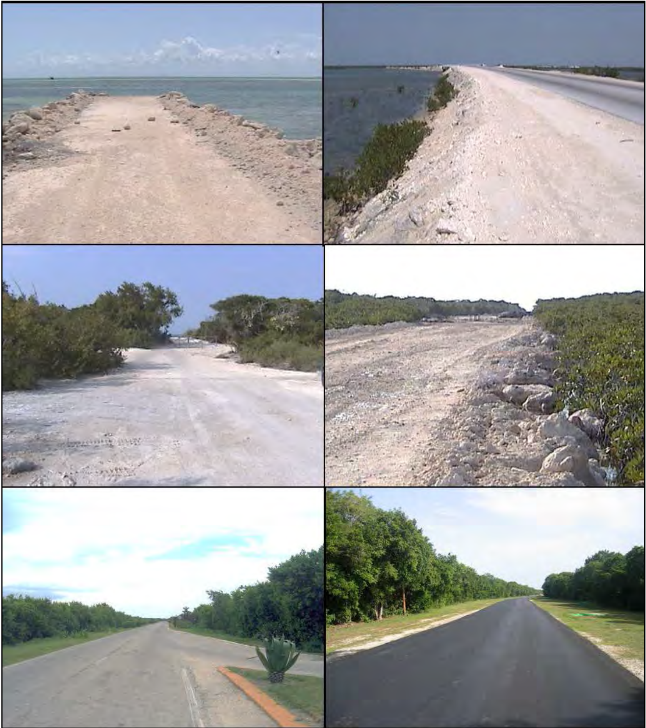
FIGURA 6.1. El desbroce para la construcción de la faja de emplazamiento de muchos viales en la cayería fue excesivo sin que se tuviera en cuenta el descomunal impacto que significa la destrucción de bosques, matorrales y manglares y el enorme gasto anual que acarrea la limpieza y chapea de los espacios remanentes. (Fotos: José M. Guzmán y Sergio Ferro)
