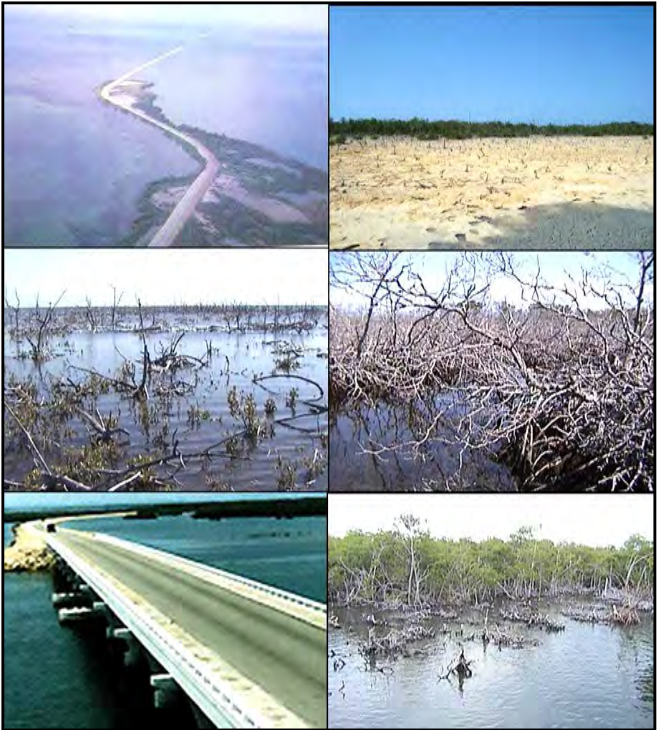
FIGURA 6.3. Los viales causan afectaciones a los manglares y hasta su muerte al atravesarlos por limitar o impedir el flujo de agua; los puentes o pasos de agua aseguran la vitalidad del ecosistema y le permiten la recuperación al manglar. (Fotos: www/ Hicuba , Alberto Álvarez y José M. Guzmán)
