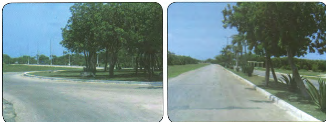
FIGURA 6. Los viales de acceso a las instalaciones turísticas son calles de estructura técnica similar a las carreteras anteriores pero suelen tener un separador central amplio con plantas de ornato; las torres luminarias están más próximas (Fotos Sergio Ferro)
