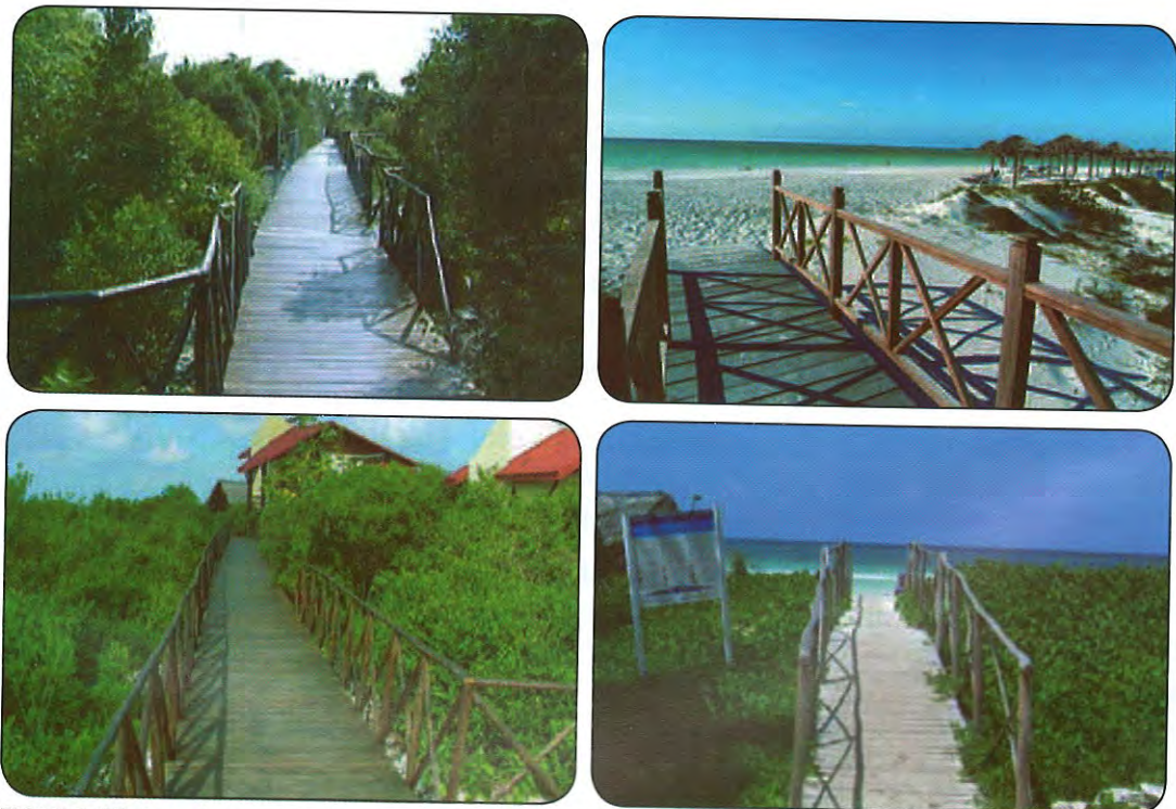
FIGURA 22. Las denominadas pasarelas o andadores de madera levantados sobre el terreno a fin de no interrumpir los procesos naturales locales se están aplicando exitosamente en muchas playas de la cayería, tanto sobre las dunas como sobre otros tipos de vegetación. (Fotos Hicuba y José Guzmán)
