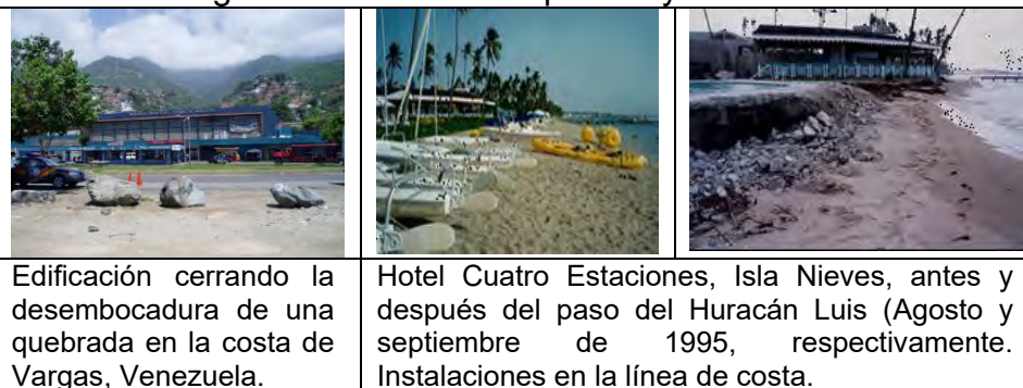
Fig. IV.1.3 Disfuncionalidades del ordenamiento ambiental como factor de riesgo ante tormentas tropicales y huracanes.
