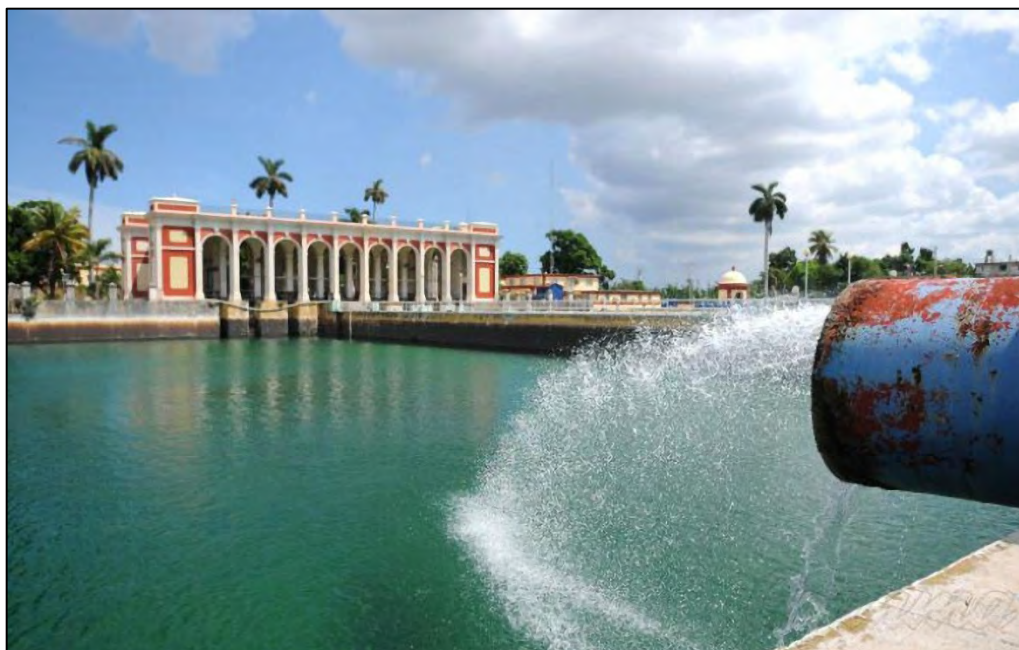
Fig. 11-1. Acueducto de Palatino, Municipio Cerro, La Habana (INRH)
