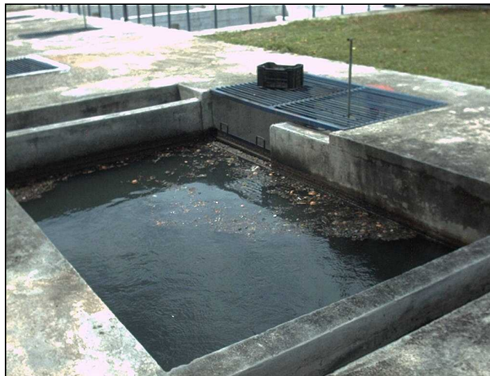
Fig. 12. Vista de uno de los procesos a que se somete el agua antes de ser devueltas al Quibú.
