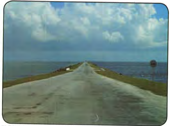
FIGURA 4. Vial sobre pedraplén con dos sendas de circulación; su carpeta asfáltica se asienta sobre un base rocosa que descansa en el fondo marino y está protegida del embate del mar por amplios hombros rocosos (Esquema: Alberto Álvarez)
