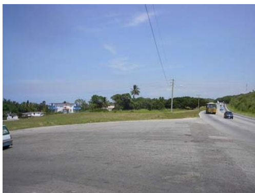
Foto 1. Vista de la Vía Blanca al Sur de Boca Ciega
