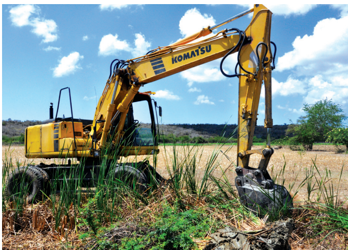
Mantenimiento de canales de drenaje en la CCSF Enrique Campos.
