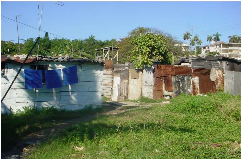
Foto 3. Viviendas construidas con materiales precarios en el barrio El Fanguito.
