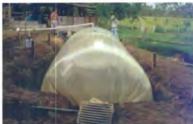
Proyecto de Biodigestor para la producción de biogás. Municipio Jimaguayú. Consejo popular: Rescate de Sanguily. Unidad 13 - 10 de la U B P C "Renato Guitart Rosell" perteneciente a la Empresa Pecuaria "Triángulo Cinco".
