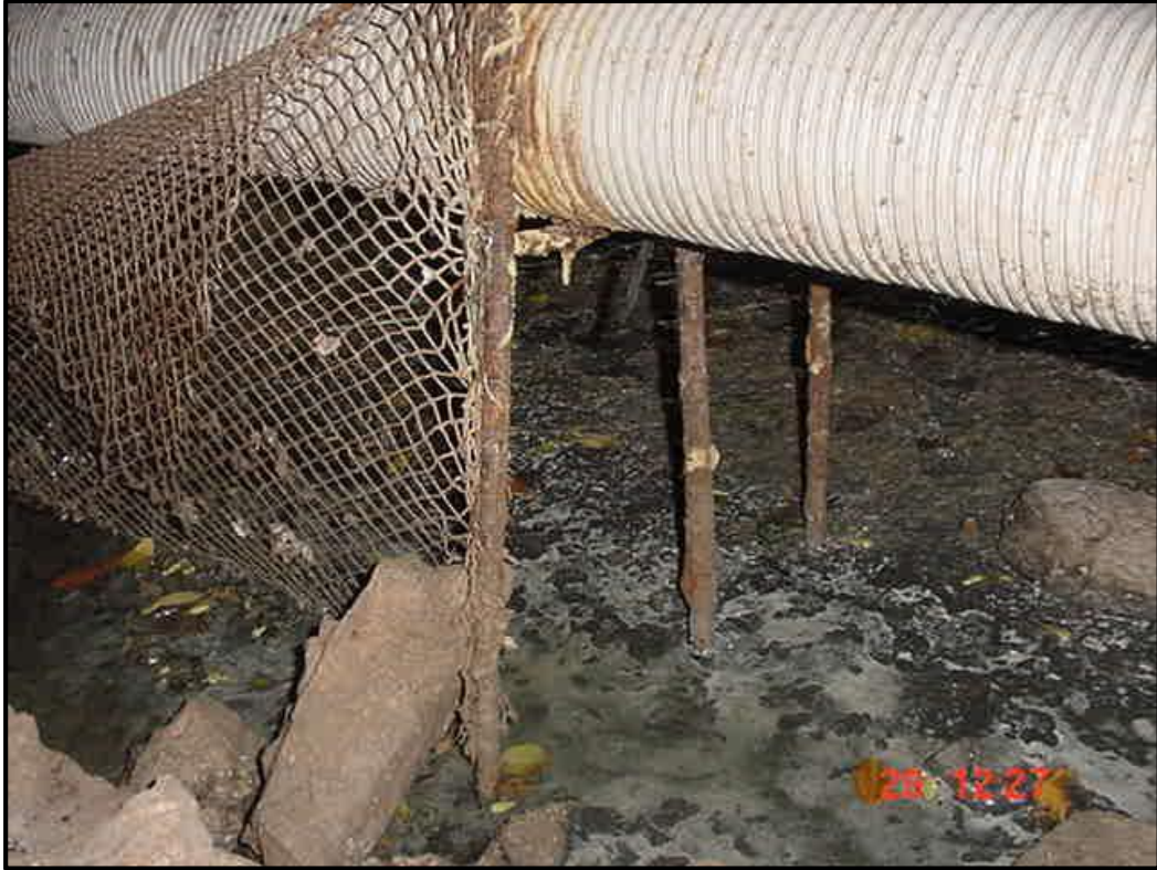
Figura 120. Vertimiento de residuales líquidos debajo del lobby del Hotel Tryp Cayo Coco en laguna Larga (2002).
