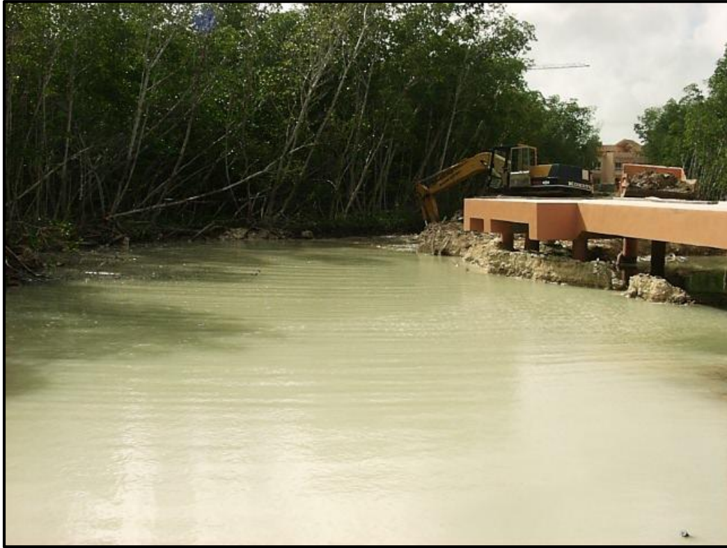
Figura 118. Dragado de los pedraplenes construidos dentro del espejo de agua de laguna Larga (finales de la década del 90).
