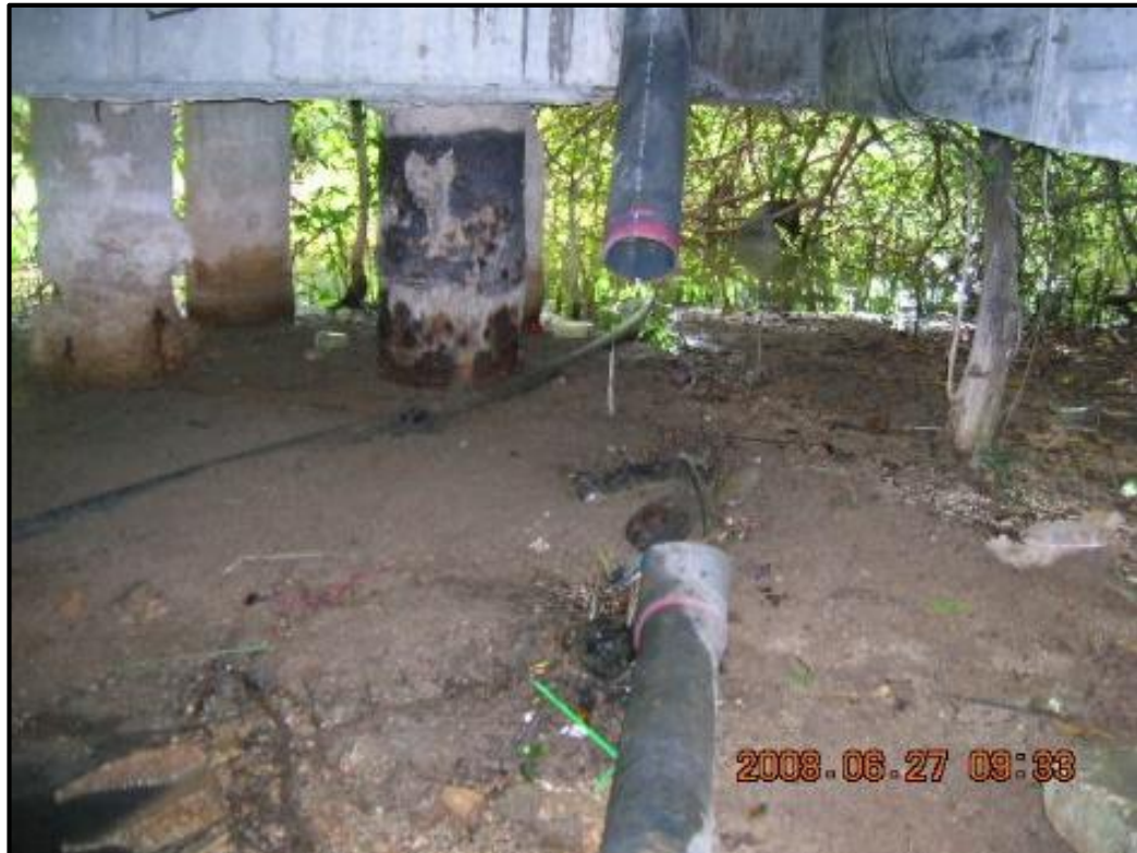
Figura 121. Vertimiento de residuales líquidos debajo del lobby del Hotel Tryp Cayo Coco en laguna Larga (2008).
