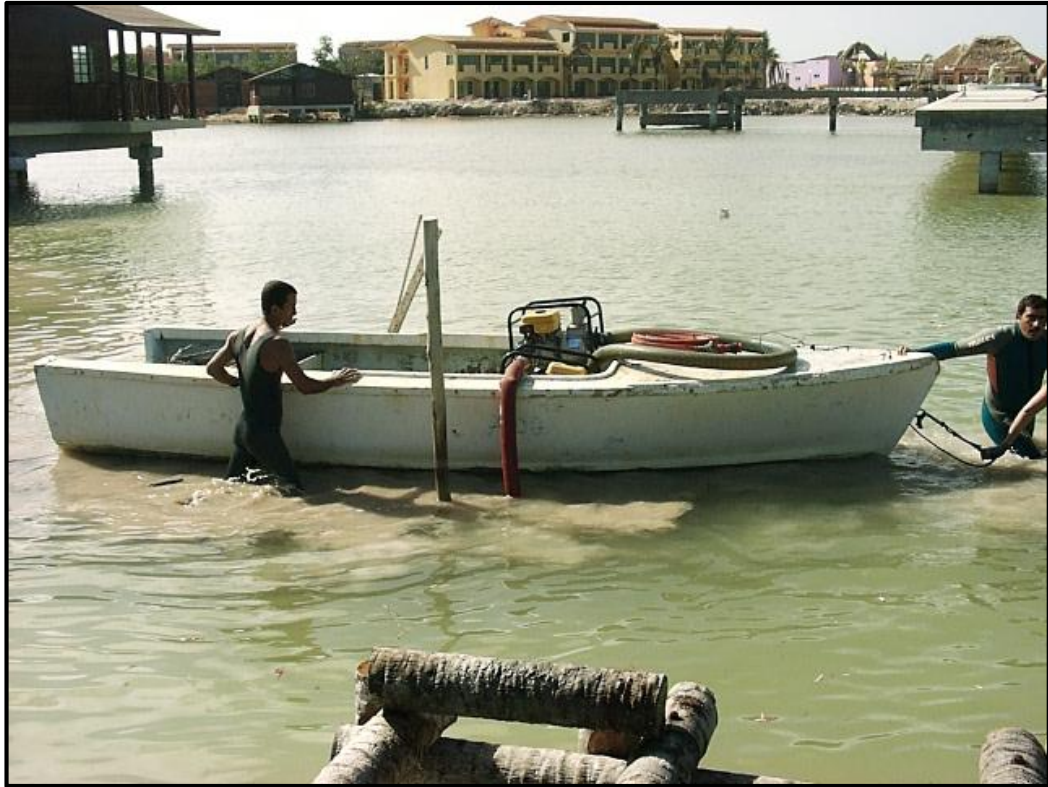
Figura 119. Dragado de los sedimentos de laguna Larga (finales de la década del 90).
