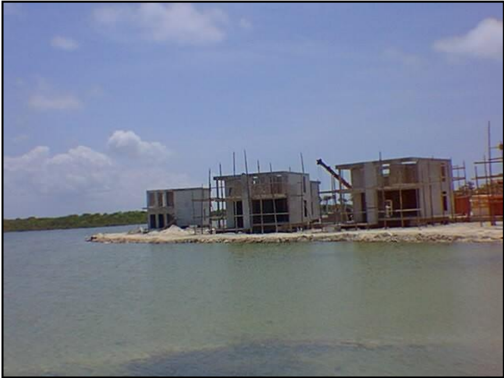
Figura 116. Relleno del espejo de agua de laguna Las Coloradas para la construcción de habitaciones del Hotel Meliá Cayo Coco (finales de la década del 90).
