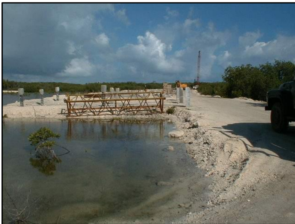
Figura 115. Relleno del espejo de agua de laguna Larga para la construcción de habitaciones del actual Hotel Iberostar Mojito (1998 – 1999).
