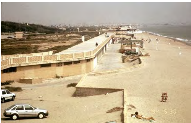
Figura 7. Detalle del paseo elevado (Foto archivo Servicio Devesa Albufera)
