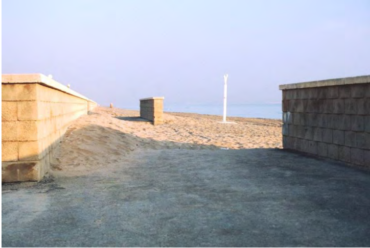
Figura 8. Detalle del paseo en la parte más al sur con un simple muro y vial (Foto archivo Servicio Devesa Albufera)
