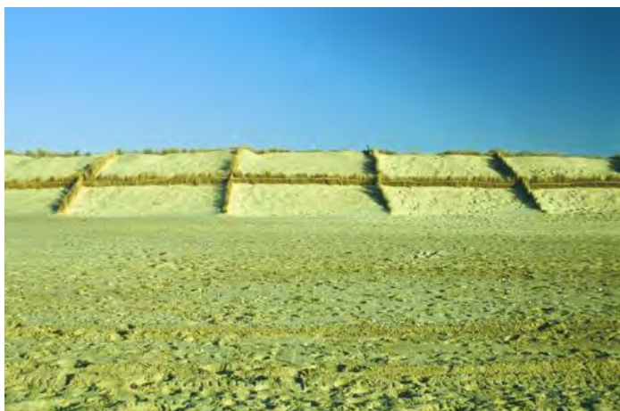
Figura 14. Empalizadas de espartina dispuestas en trama ortogonal (Foto archivo Servicio Devesa Albufera).
