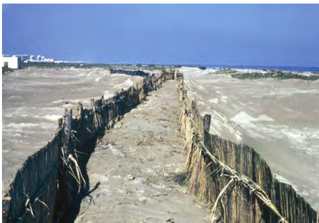
Figura 9. Barreras de cañas utilizadas en la experiencia de 1981(Foto archivo Servicio Devesa Albufera)
