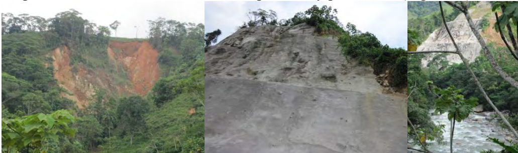
Figura 1. Desprendimientos de taludes, lodos y suelo en la Cuenca del Río Hacha
