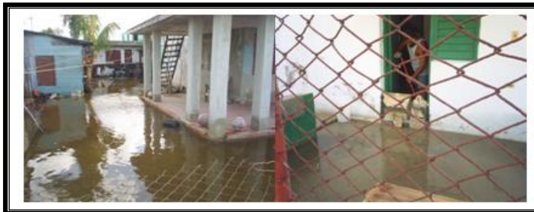
Fig. 18 y 19. Viviendas inundadas. Guanabo
