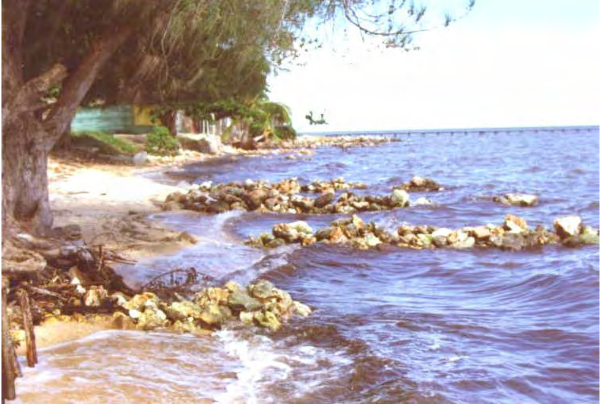
Foto 3. Playa Mayabeque, provincia La Habana. Construcción de espigones y muros que han acelerado los procesos de erosión y el deterioro de las condiciones estéticas de la playa.
