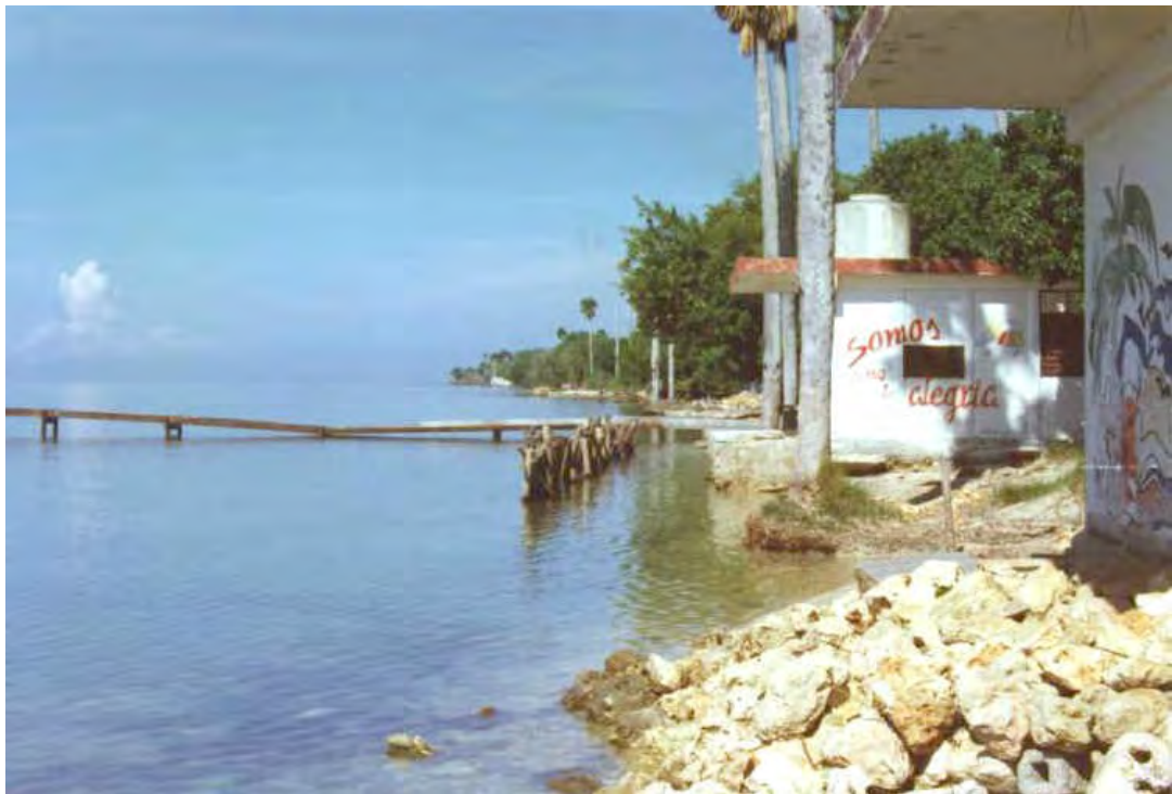
Foto 5. Playa La Pepilla. Instalaciones costeras invadidas por el mar.
