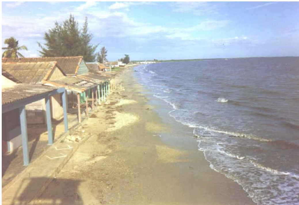
Foto 2. Playa Galafre, Pinar del Río. Instalaciones construidas sobre la duna y muy próximas a la línea de costa.
