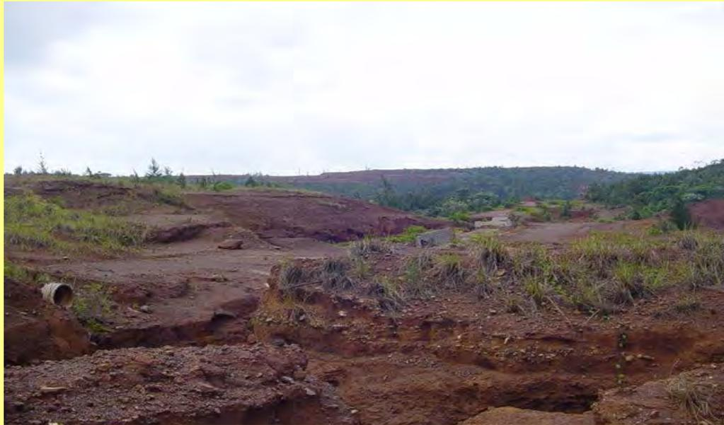
Fig. II.9. Cárcavas en camino provocadas por el uso de alcantarillas cerradas (Urbino, 1998)
