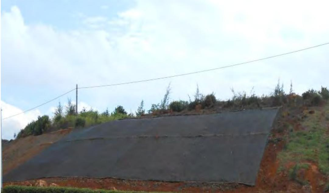
Fig. III.21. Uso de mantas antierosivas para controlar los taludes de las presas de cola, Moa. (Urbino, 2015)
