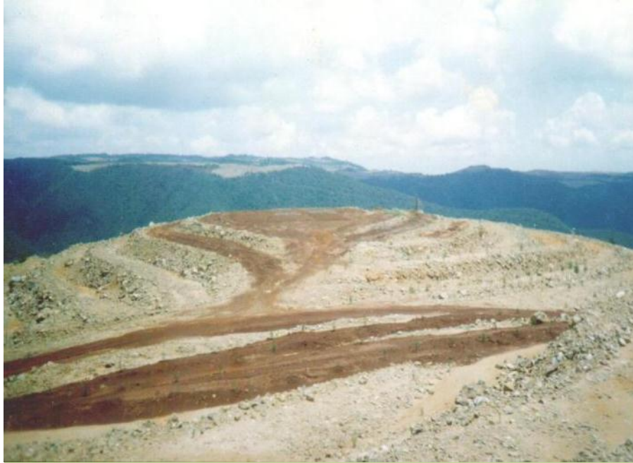
Fig. IV.13. Conformación del terreno en terrazas de plataforma plana, con escombro estéril. (Pinares S. A. 1999)
