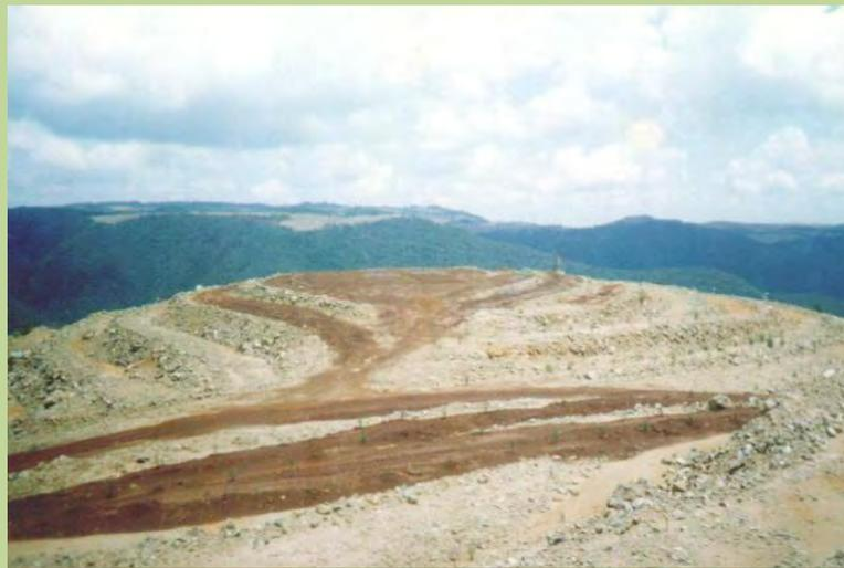
Fig. V.17. Rehabilitación Física del terreno en terrazas.
