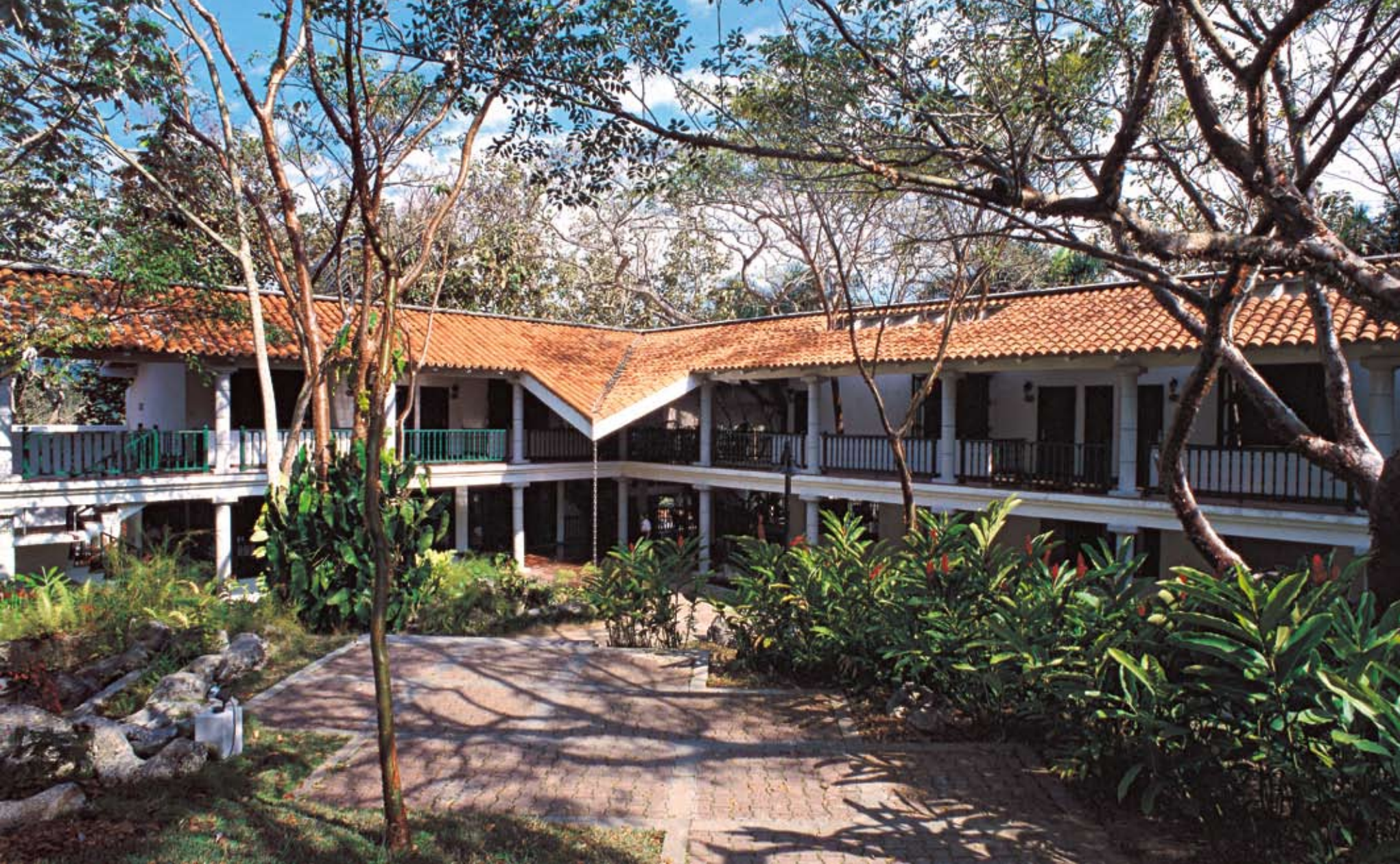
FIG. 30. El diseño y la instalación cuidadosa de construcciones en ambientes previamente naturales, como es el caso del hotel Moka en la sierra del Rosario, permiten la conservación y reproducción de muchas especies.
