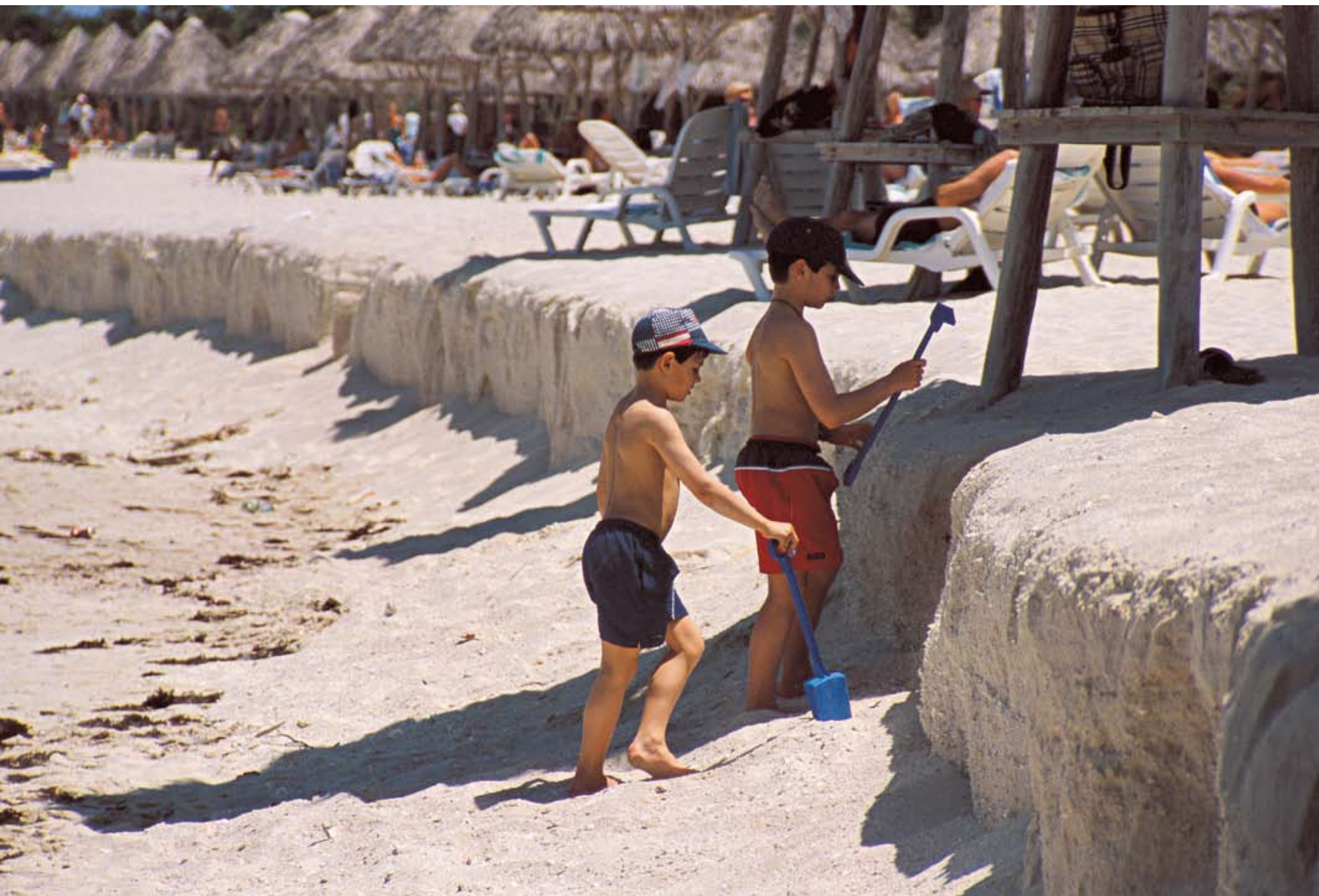
FIG. 619. Las playas han sido afectadas por la erosión.
