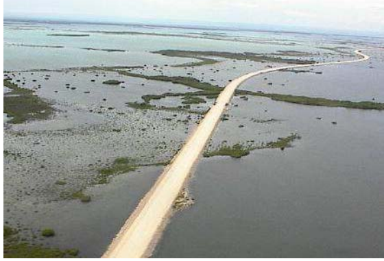
Figura 9. Vista aérea del pedraplén que parte de Caibarién a los cayos Las Brujas, Ensenachos y Santa María
