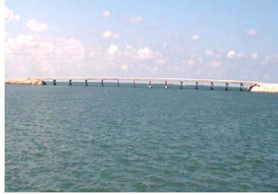
Figura 10. Vista desde el mar de uno de los puentes del pedraplén Caibarién, Las Brujas, Ensenachos y Santa María
