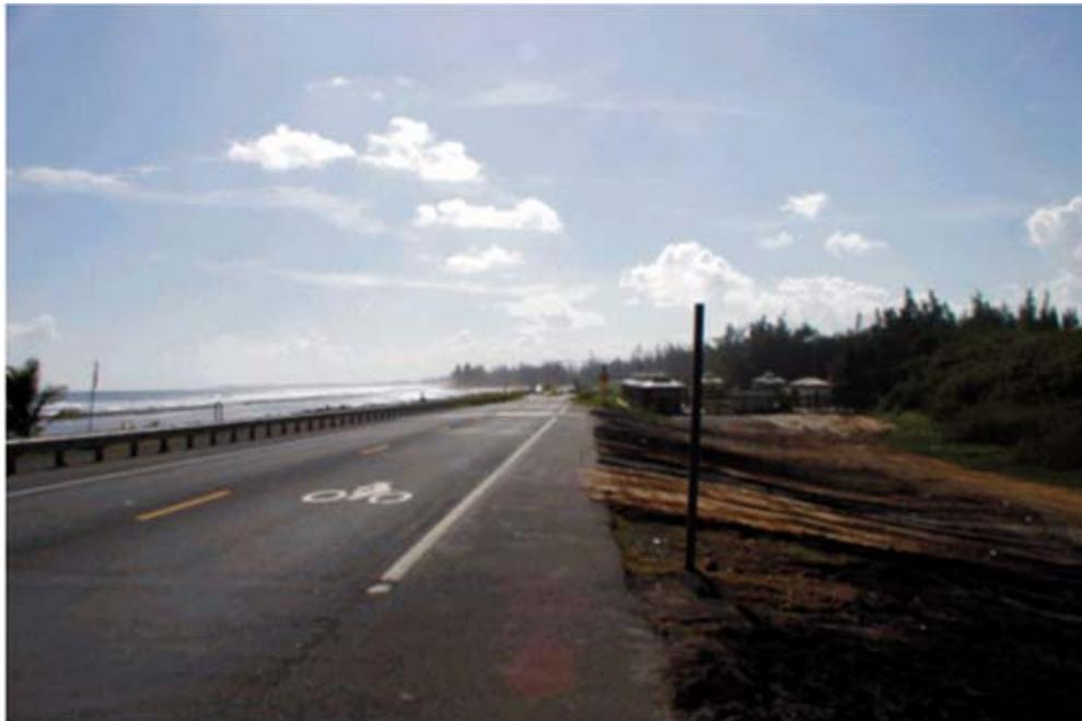
**Figura 4. Carretera Piñones sobre terraplén artificial para evitar entradas del mar, municipio de Loíza**
