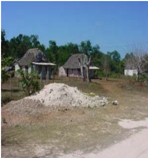
Fotografía 4. Vista exterior de viviendas de la comunidad El Rincón. Tomada por Lilian Nuñez Moreno.
