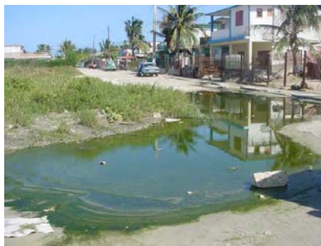
Fig. 79. Fosa rota en la zona urbanizada (Unidad I).
