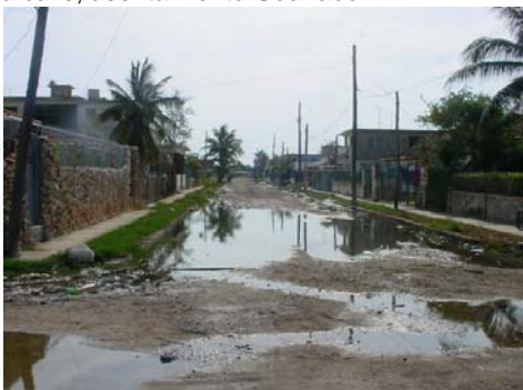
Fig.75. Fosa rota en la zona urbanizada
