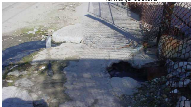
Fig.77. Fosas en mal estado que vierten hacia el subsuelo o directamente hacia el mar
