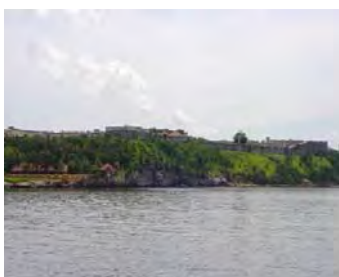
Foto 33. Fortaleza de San Carlos de La Cabaña.
