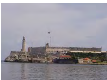
Foto 32. Vista del Castillo de los Tres Reyes del Morro
