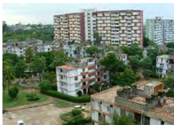
Foto 22. Vista de la urbanización Camilo Cienfuegos
