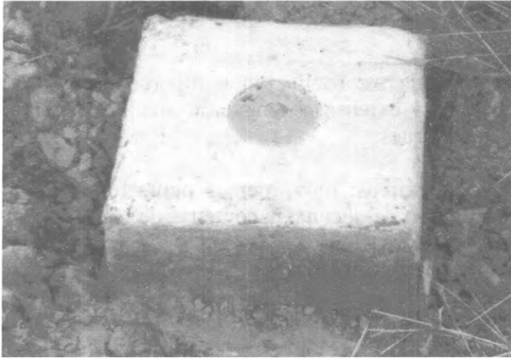
Fig. 11. Monumento geodésico ( http://www.inegi.org.mx/geo/contenidos/geodesia/vertical.aspx ).
