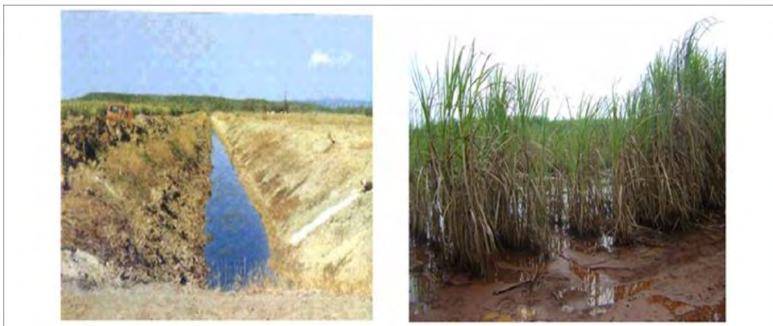
A B Figura 10.11. A. Canal de drenaje. B. Campo de caña afectado seriamente por los efectos del mal drenaje (inundación por más de tres días).
