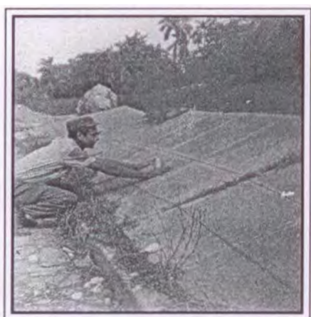
Figura. 1. Ascenso de pavimentos. (Fuente: Lewis, 1968).
