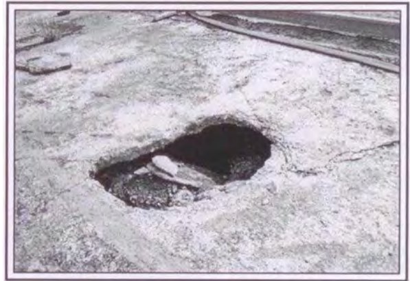
Figura 8. Formación de voladizos. (Fuente: fotografía tomada por el autor).
