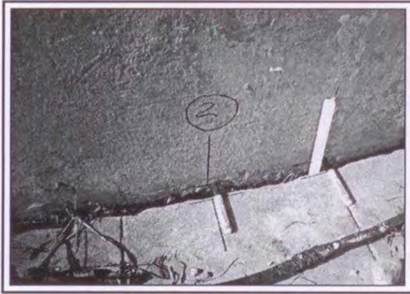
Figura 7. Basculamiento del tanque. (Fuente: fotografía tomada por el autor).
