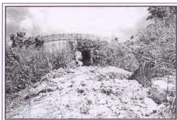
Figura 44. Oquedades en las laderas del tanque.
