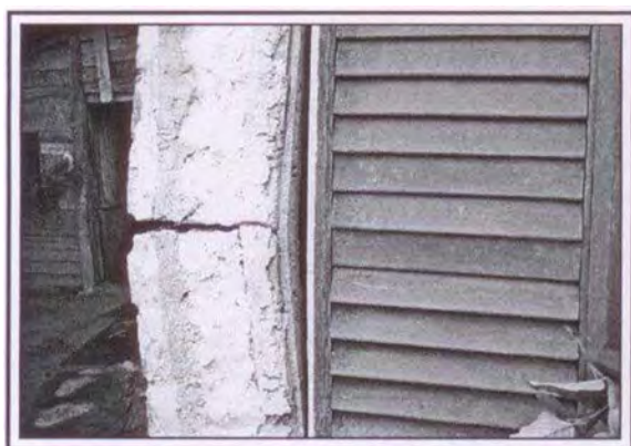
Figura 54. Partidura de una columna. (Fuente: fotografía tomada por el autor).
