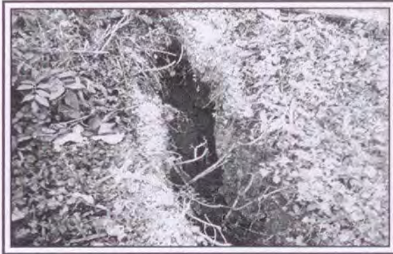
Figura 47. Grieta de 0,120 metros. (Fuente: fotografía tomada por el autor).
