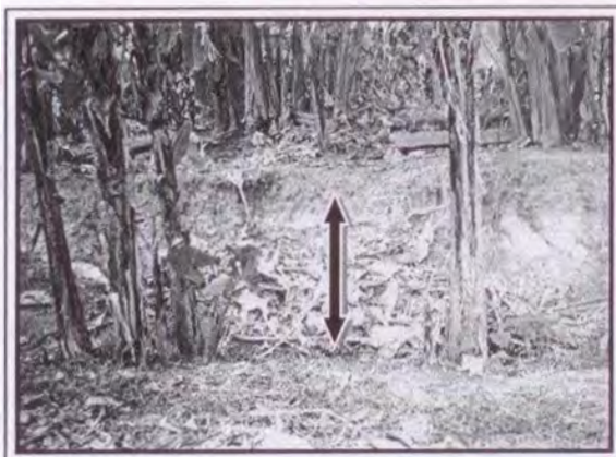
Figura 52. Descenso de la cabecera. (Fuente: fotografía tomada por el autor).
