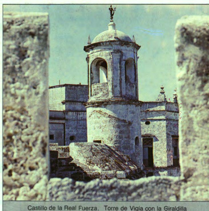
Castillo de la Real Fuerza. Torre de Vigía con la Giraldilla
