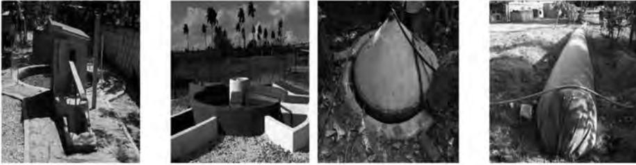
Cúpula fija del modelo “Nicarao” Cúpula fija modelo “GBV” Campana móvil
