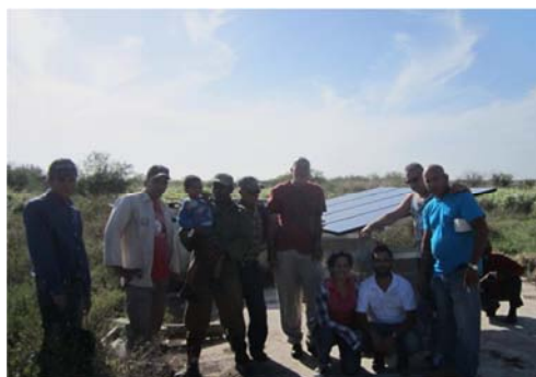
Productores y especialistas de CUBAENERGÍA luego de la instalación del sistema fotovoltaico que proveerá de energía eléctrica a uno de los ranchos existentes en los campos arroceros de Los Palacios.
