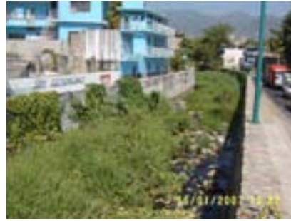
Figura 8. Hierba, maleza y aguas residuales
