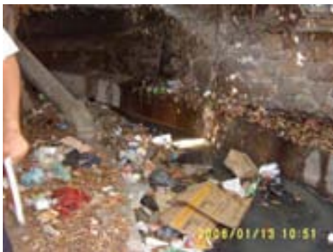
Figura 3. Depósito de residuos sólidos urbanos
