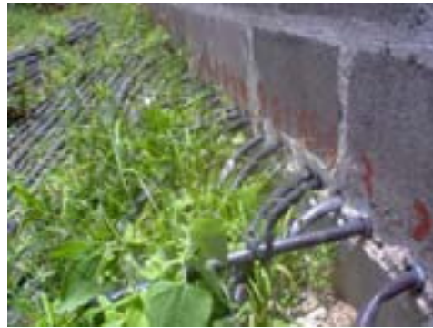
Foto 3 y 4 cajas receptoras de agua
