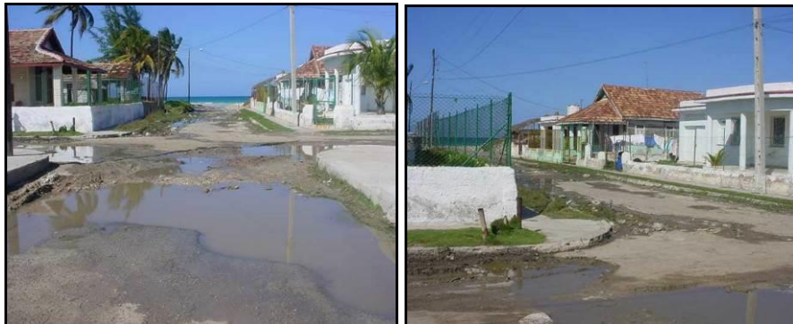
Fig. 29. Calles en mal estado que conducen a la playa de Guanabo.
