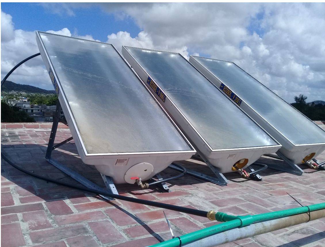
Figura 3. Instalación de calentadores solares
