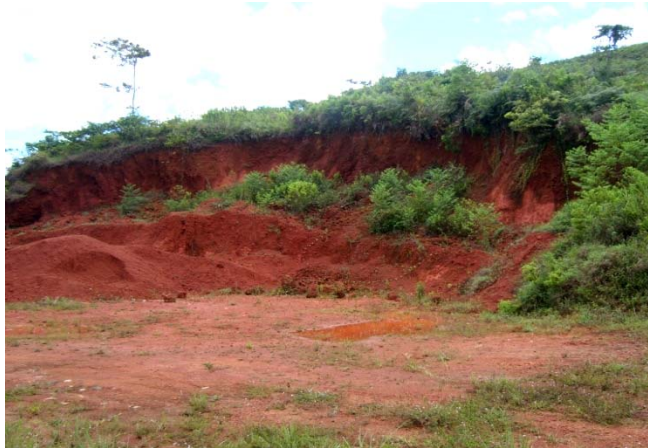
Figura 12. Préstamo de suelos del orden entisoles observado en el corte del vial Paují-Santa Elena. Fuente: Archivo personal del autor
