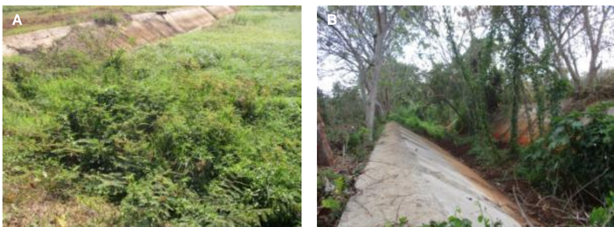
Figura 5: Fuentes de riego secas y totalmente cubiertas de vegetación, en su mayoría compuesta por plantas exóticas. A, embalse. B, canal.
