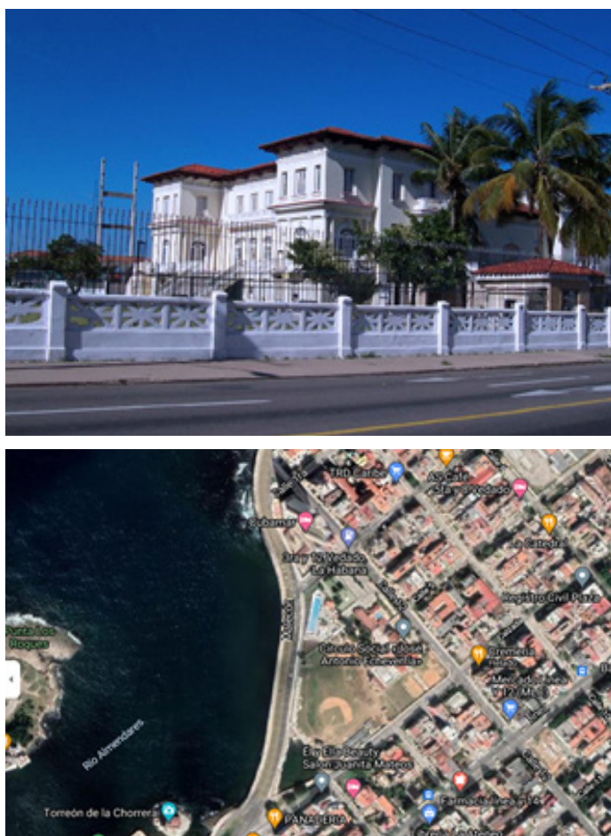
Figura 1.- Fachada del “Club 500” y vista en planta (satelital).
