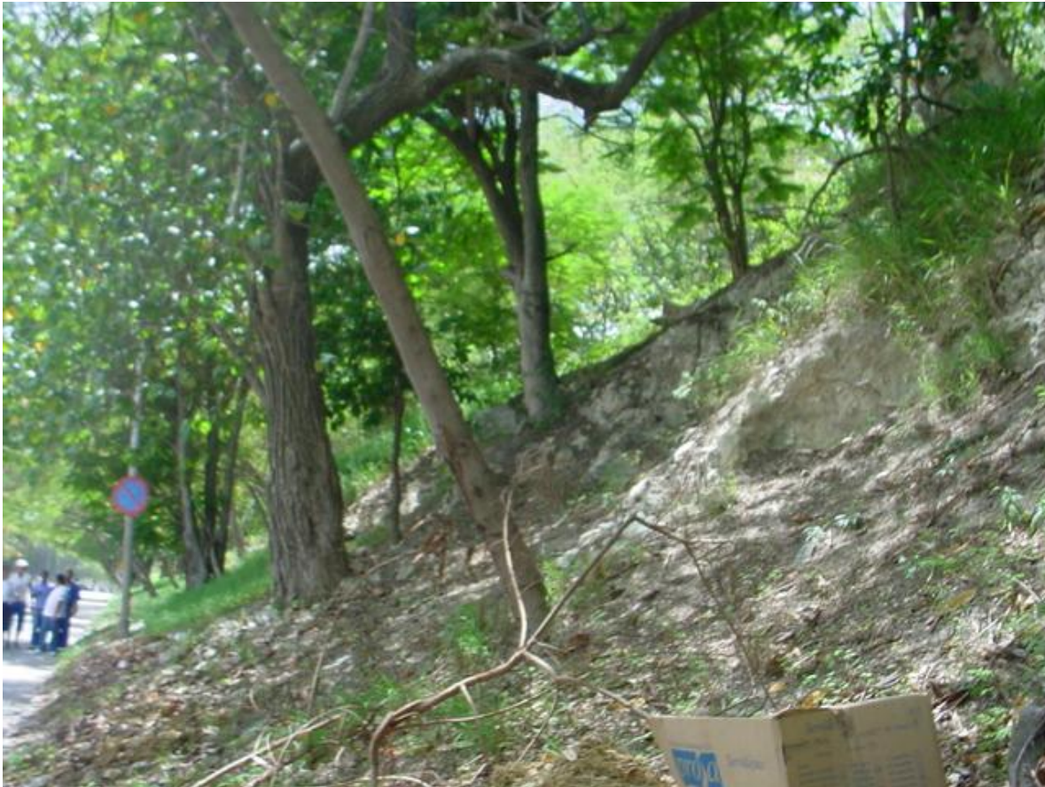
Fig. 1 Ladera meridional de la Colina Príncipe. Obsérvese su inestabilidad
