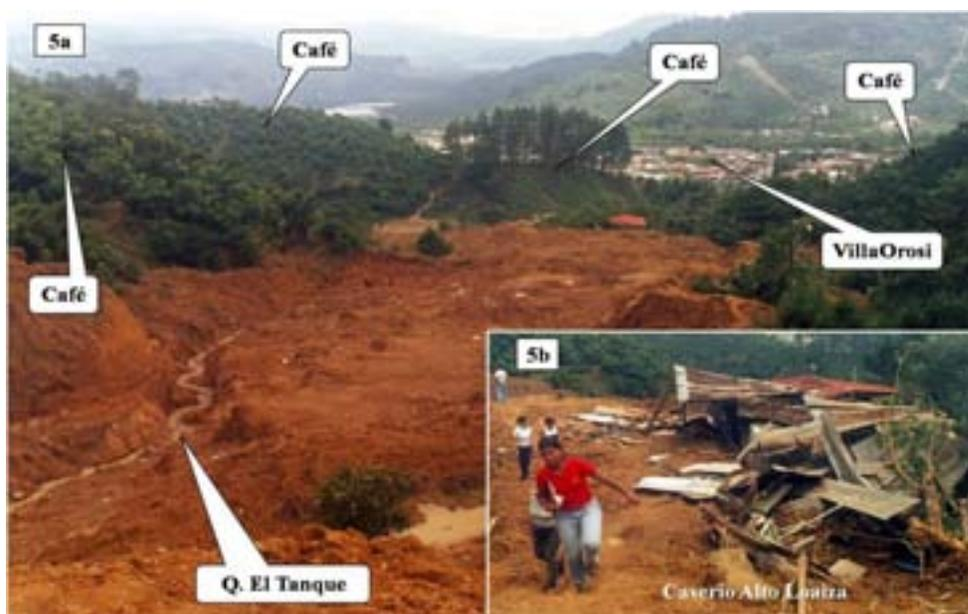
**Fotografía 5. Deslizamiento de 2 millones de m<sup>3</sup>, destruyó 13 casas en el Alto Loaiza (ICE, 2002), dejó 6 personas fallecidas y destruyó las fincas de café que estaban en su camino. Sus lodos llegaron hasta el centro de la Villa de Orosi. (Imagen V. Cortés).**
