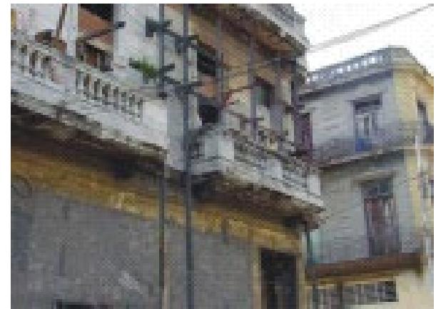
Apuntalamiento del inmueble
