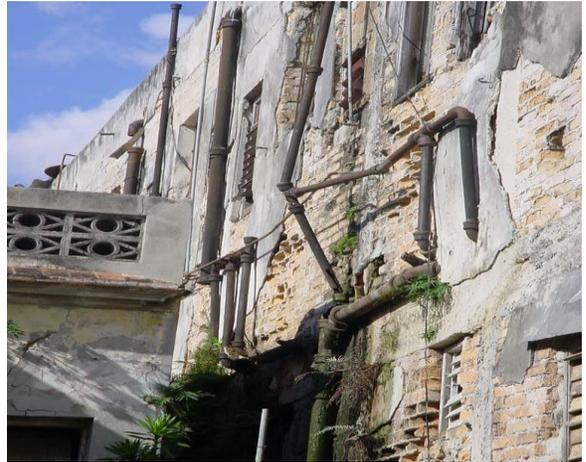
**Foto No. 14 Deficiente estado técnico de la red de abasto de agua potable.**
