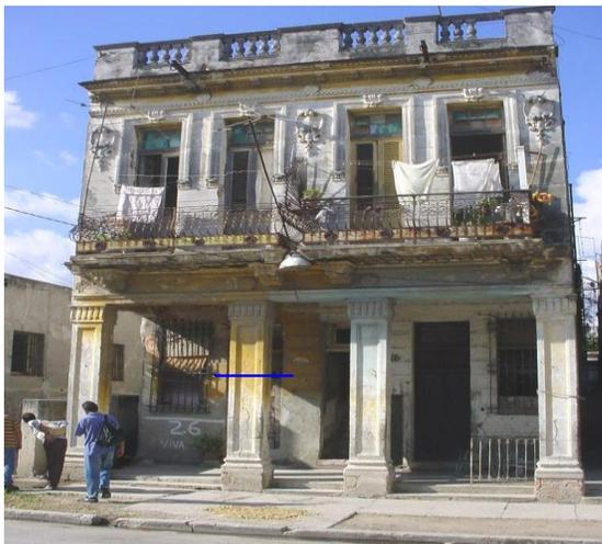
**Foto No. 24 Vivienda múltiple seriamente afectada por las inundaciones. Obsérvese la marca de la altura del agua que fue alcanzada durante un periodo de lluvias intensas en Agosto del año 2003.**
