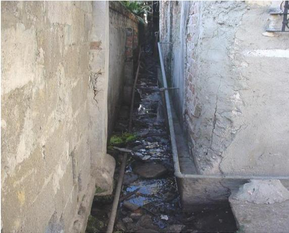
**Foto No. 13 Tuberías de agua potable en mal estado en contacto con vertimiento de aguas albañales.**
