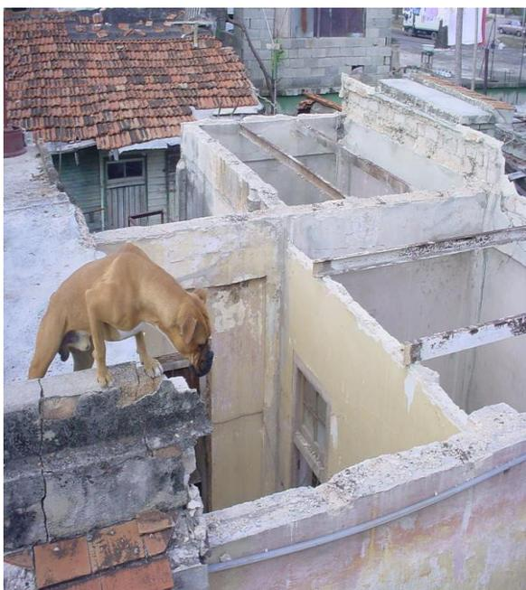
**Foto No. 8 Derrumbe total de techos cuando el ciclón del mes de Agosto.**
