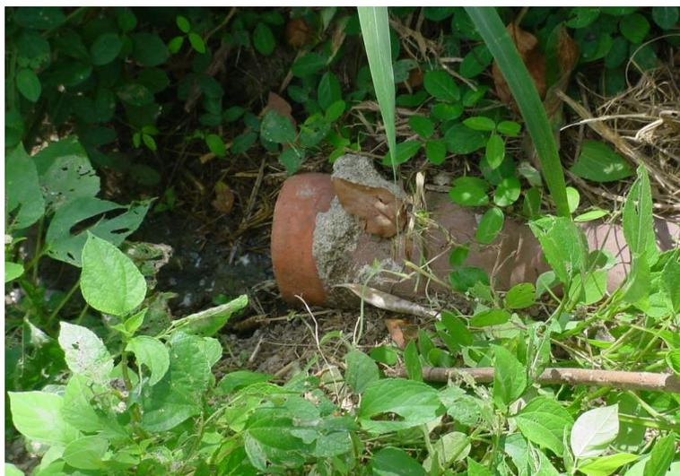
**Foto No. 1 Descarga directa al Río Luyano de residuales líquidos provenientes de una cochiguera en una granja estatal**
