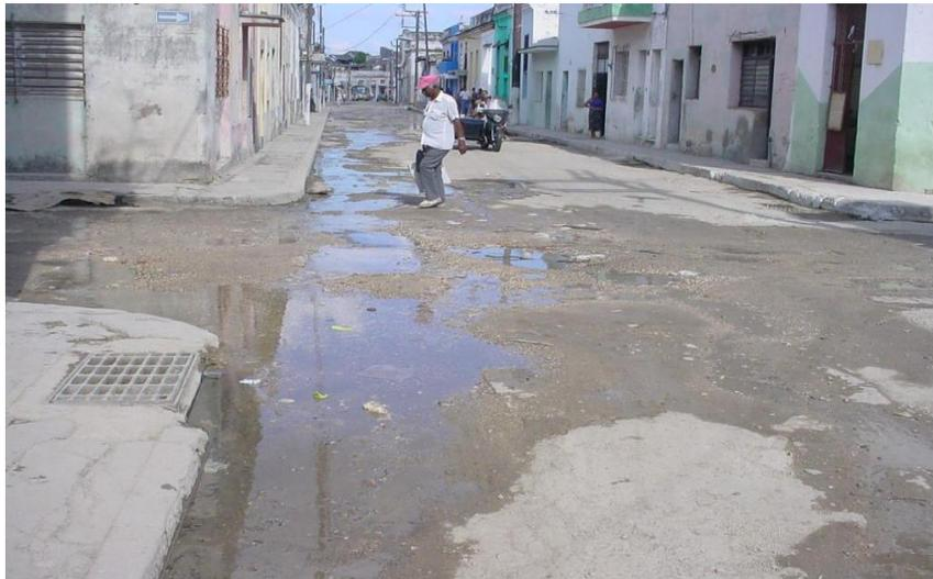
**Foto No. 6 Calles con numerosos baches y salideros de agua potable y albañales.**
