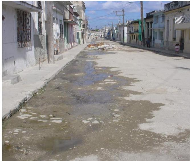
**Foto No. 26 Numerosos desbordamientos de albañales que ponen en peligro la potabilidad del agua de consumo y la limpieza del Río Luyano.**
