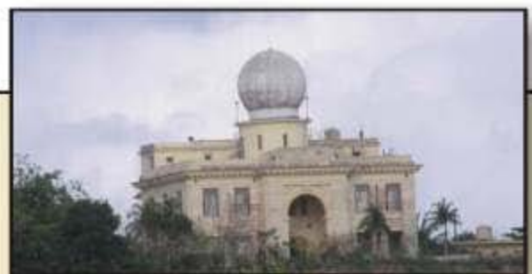
Estación de Casa Blanca, donde radica el Instituto de Meteorología cubano.
